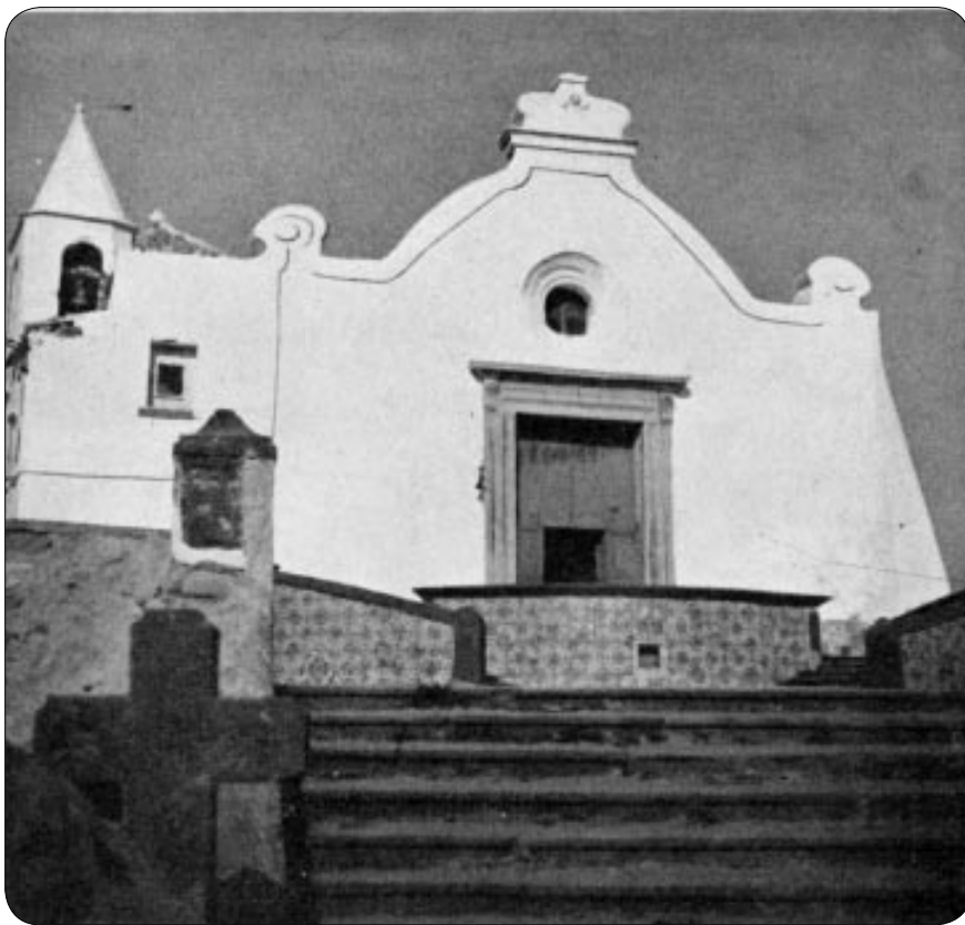
Ischia: La bianca facciata della Chiesa del Soccorso
